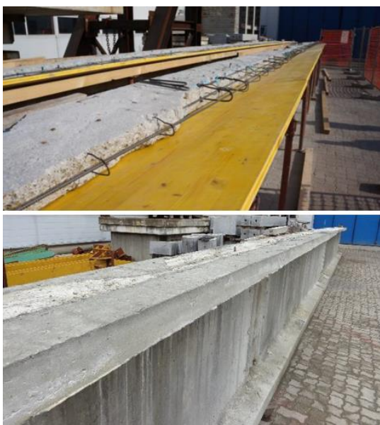
Figura 3. Rinforzo del bulbo superiore delle travi.
