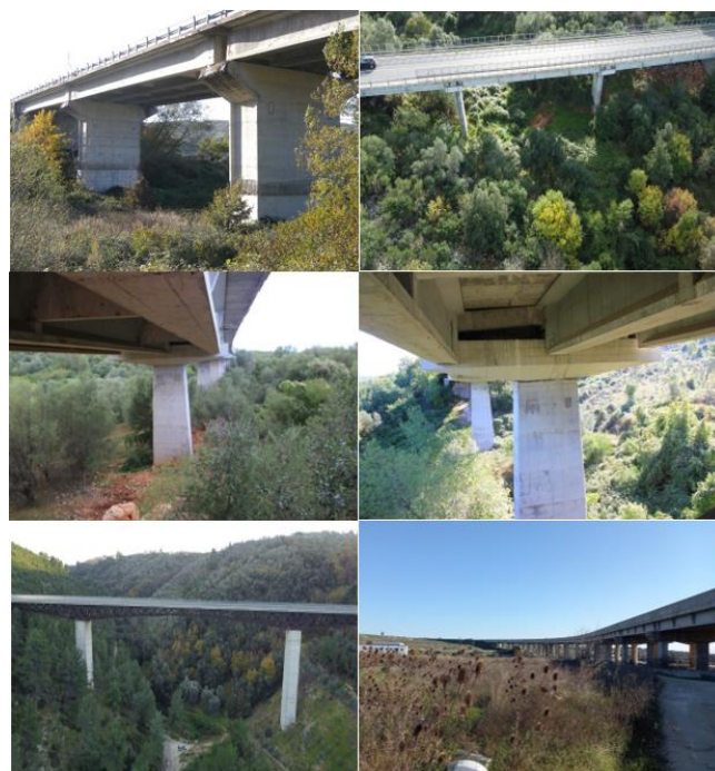
Figura 9. Viadotti Santa Lucia, Lampione, Chiancone, Del Lauro, Asciatizza e Ponte SS7.
