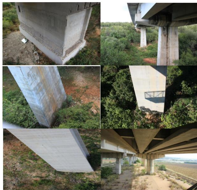
Figura 10. Foto relative ai viadotti Santa Lucia, Lampione, Chiancone, Del Lauro, Asciattizza e ponte SS7 che mostrano l'assenza di fenomeni erosivi localizzati.
