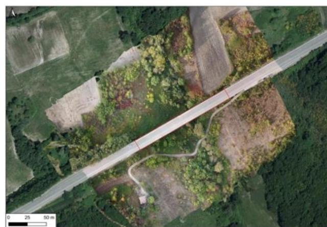
Figura 14. Ortofoto del viadotto Santa Lucia, evidenziato dalla cornice rossa.
