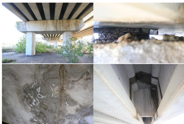
Figura 6. Foto relative al ponte SS7
