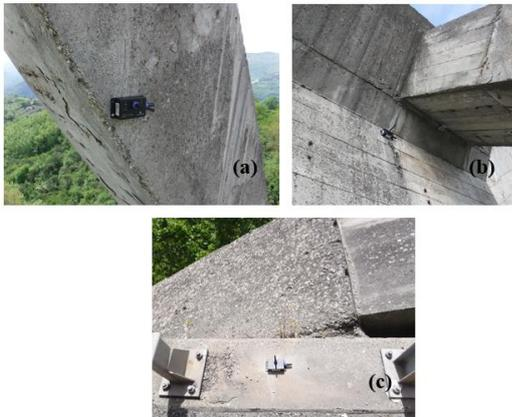
Figura 11. Accelerometri installati su: strallo 2 (b), antenna SA – innesto strallo 3 (a) e cordolo destro traversone (c).
